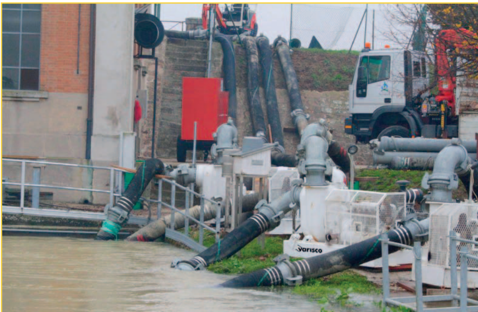
Assèchement de zone inondée Afwatering van het overstroomde gebied Entwässerung eines überschwemmten Bereichs
