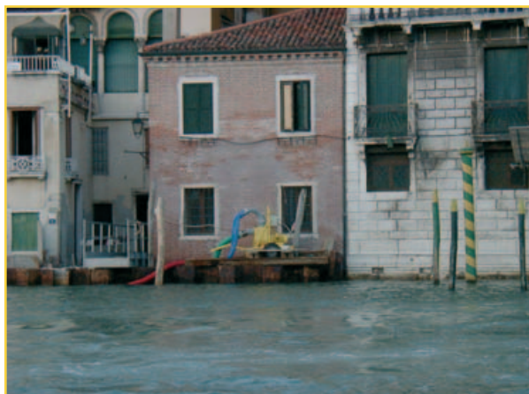
Travaux de conservation à Venise Instandhoudingswerken in Venetië Erhaltungsarbeiten in Venedig
